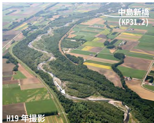
写真 2-6 中島新橋付近
