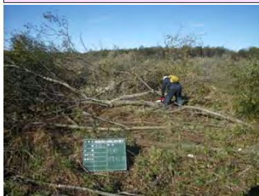
人力での河道内樹木伐開状況
