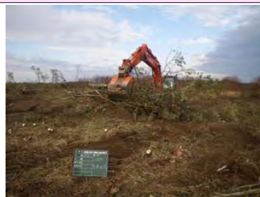
重機での河道内樹木伐開状況
