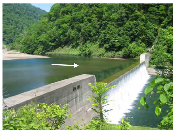
写真1-4 札内川12号えん堤
