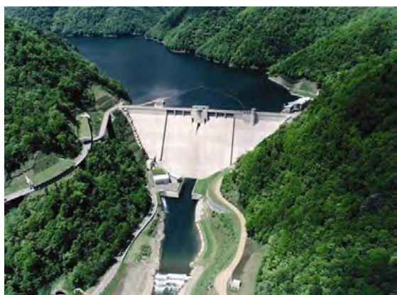
写真1-3 札内川ダム（平成10年供用開始）
