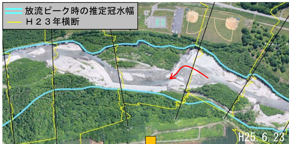
比較的变化が大きかったKP33.4~34.0の状況
