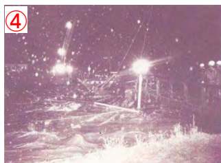
▲S56年8月洪水(帯広市) 売買川鉄平橋の撤去
