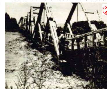
▲S37年8月洪水(帯広市) 落橋寸前の大正橋
