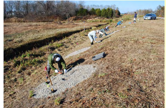
植樹箇所全景（堤防堤内側の腹付け盛土）
