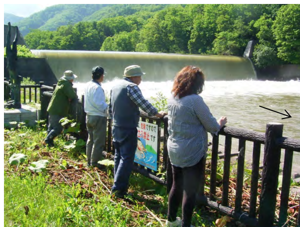
見学状況（1号砂防堰堤）
