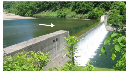
札内川 12 号砂防えん堤（S61 年竣工）
