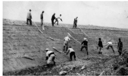
昭和 36 年当時の堤防工事（札内川）
