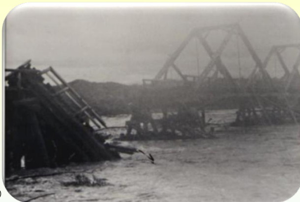
洪水で倒壊・流出した上札内橋(S37)
