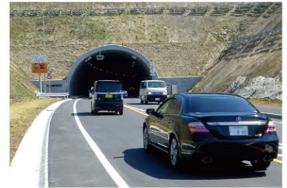
H30.3.17開通 国道5号 忍路防災
