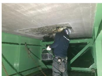
橋梁の老朽化対策（床版補修）
