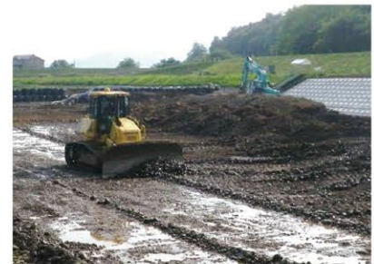
豊国地区 河道掘削 (ICT施工による敷均し状況)
