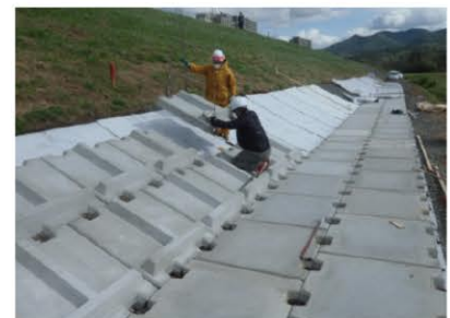
蘭越地区 堤防裏法尻補強状況
