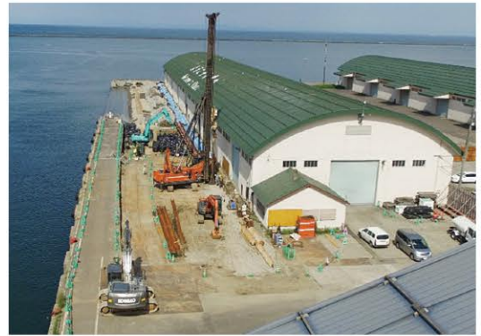
小樽港 水深10m岸壁改良状況
