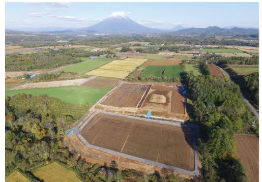
農地の区画整理工事の実施状況
