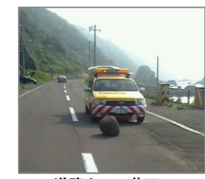
道路上への落石
