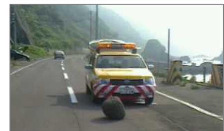
道路上への落石
