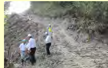
工事現場の確認状況
