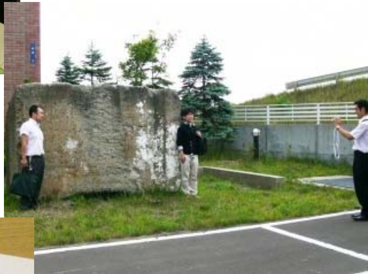
これは廣井勇（初代小樽築港事務所長）が作った北防波堤斜塊の実物です 記念撮影ではなく、大きさ比較対象撮影です
