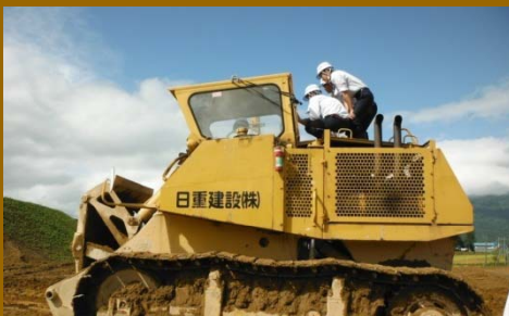
工事施工後(5ha)のほ場を見学
