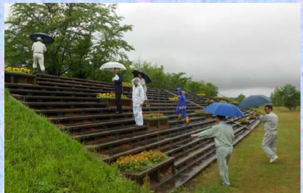
ランラン公園堤防護岸点検状況
