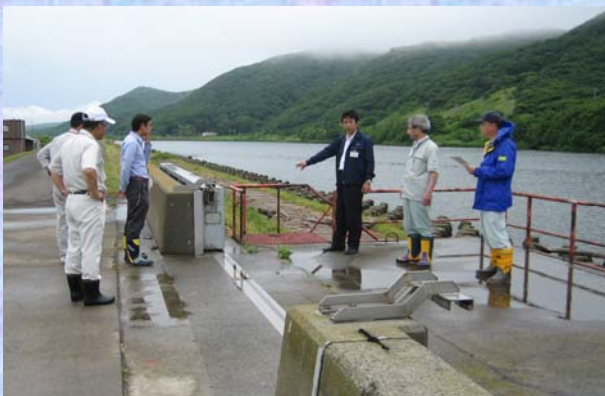
港地区堤防(特殊堤)点検状況
