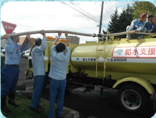
札幌市水道局南部水道センター 厚別分室 で給水車に水を補給
