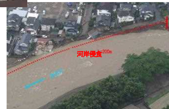
河岸侵食に伴う 家屋倒壊等
