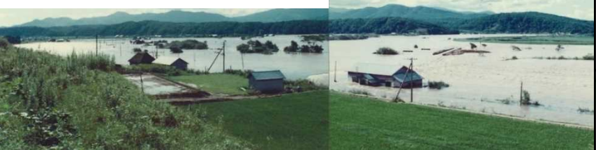
昭和50年8月台風第6号(三和築堤浸水状況) 被害家屋408戸、田畑流出浸水3,508ha
