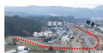
移転家屋の建設が進む状況
