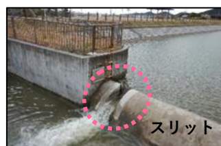
▲スリットの設置状況
