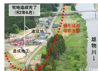
移転先宅地完成完了状況
