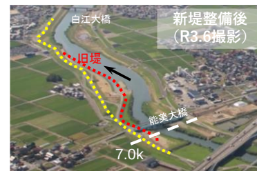
引堤(石川県梯川水系梯川)
