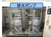
地下への浸水防止対策
