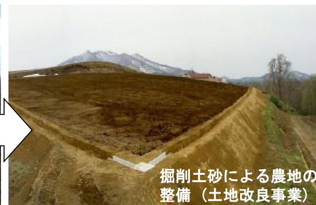
掘削土砂の再利用 (河道掘削)
