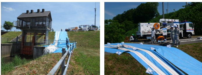
排水ポンプ車による排水（訓練）
