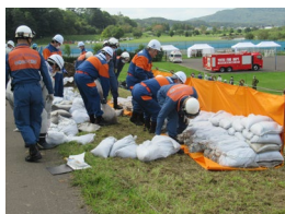
積み土の工法
