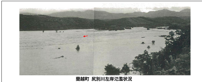
蘭越町 尻別川左岸氾濫状況
