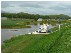
蘭越町 原田樋門 内水氾濫状況
