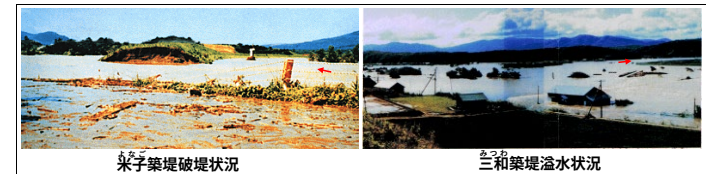
米子築堤破壊状況
