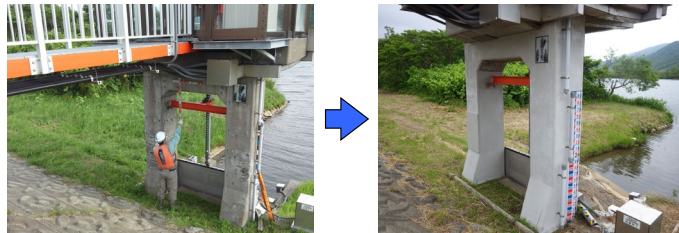
樋門門柱の補修
