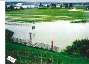
旧蘭越築堤内水氾濫状況
