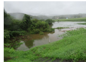
原田樋門地先 内水氾濫状況
