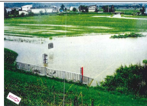
旧蘭越築堤内水氾濫状況
