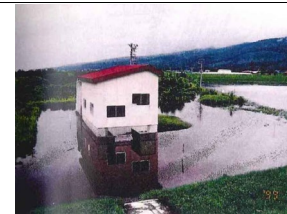
初田第一樋門付近内水氾濫状況
