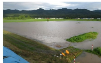
小林樋門地先 内水氾濫状況
