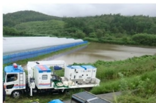
三浦樋門地先 内水氾濫状況
