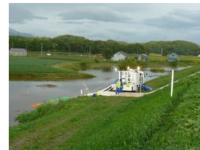
蘭越町 原田樋門 内水氾濫状況
