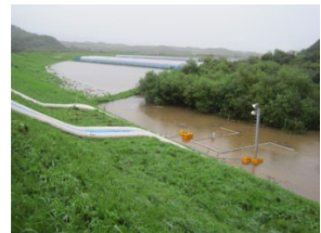
蘭越町 三浦樋門 内水氾濫状況
