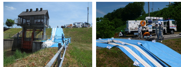
排水ポンプ車による排水（訓練）
