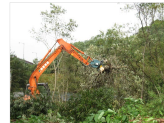
樹木伐開工事
