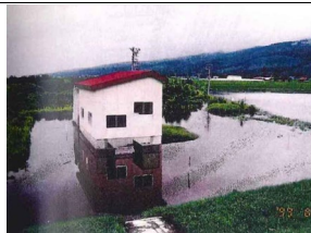
初田第一樋門付近内水氾濫状況
