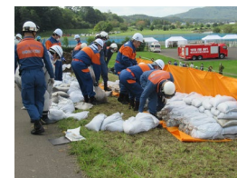
積み土の工法
