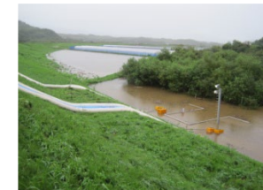
蘭越町 三浦樋門 内水氾濫状況
