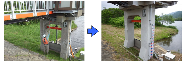
樋門門柱の補修
