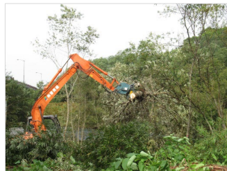
樹木伐開工事
