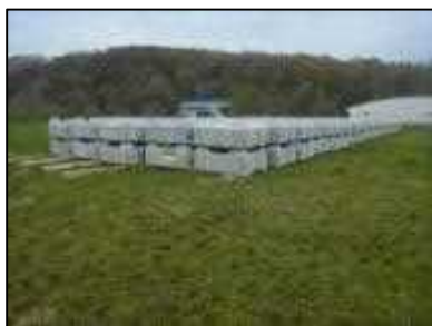
大曲資材備蓄基地 水防資材備蓄状況
