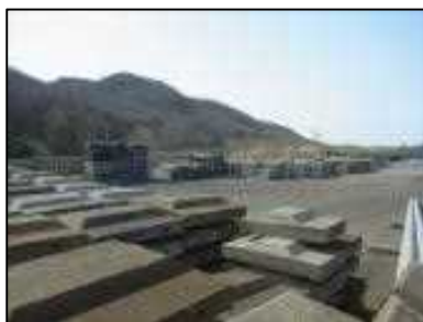
名駒資材備蓄基地 水防資材備蓄状況
