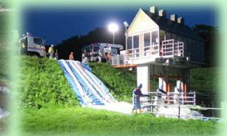
夜間排水作業訓練
