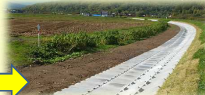
堤防法尻補強工事(継続実施)
