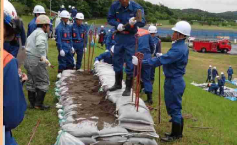
洪水の勢いを抑え河岸や堤防を守る 木流し工
