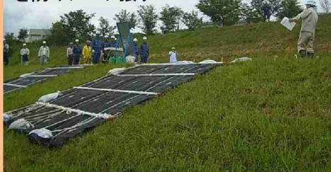
洪水による堤防の漏水や決壊（崩れ） を防ぐシート張り工
