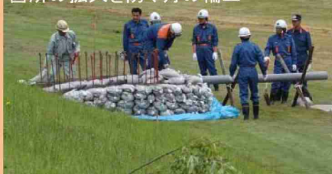
洪水による堤防の漏水発生時に漏水 箇所の拡大を防ぐ月の輪工
