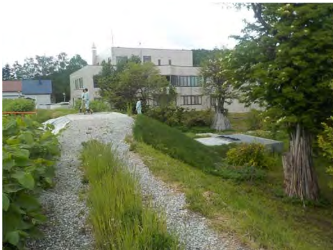
喜茂別川丸子樋門釜場（平成26年度完成）
