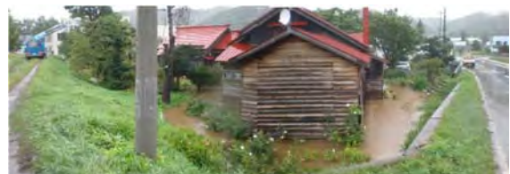
丸子樋門内水氾濫状況（平成23年9月6日）
