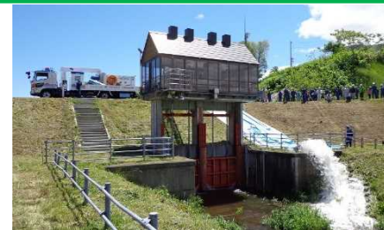
排水ポンプ車訓練
