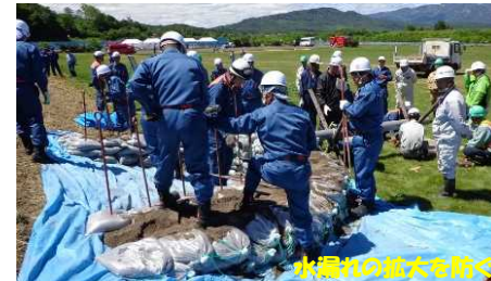
水の漏れを拡大を防ぐ 月の輪工
