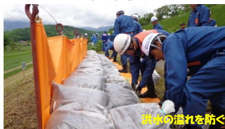
積み土のう工
