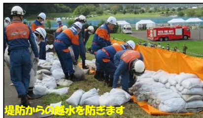
改良積み土のう工の設置状況
