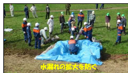
月の輪工の設置状況
