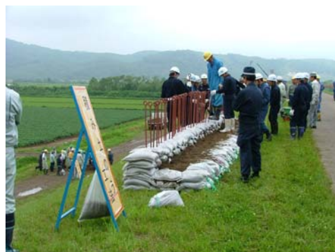
水防工法訓練
