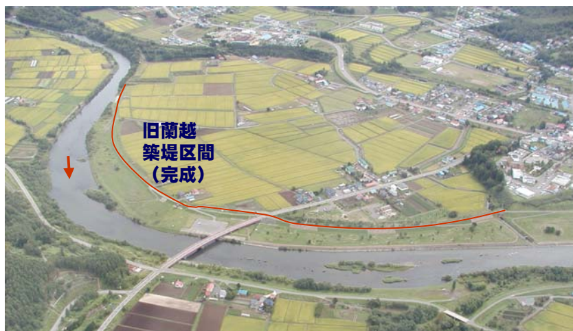
旧蘭越築堤区間 現在（平成18年）
