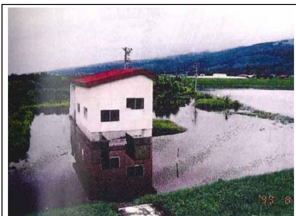
はつた 初田第一樋門付近内水はん濫状況
