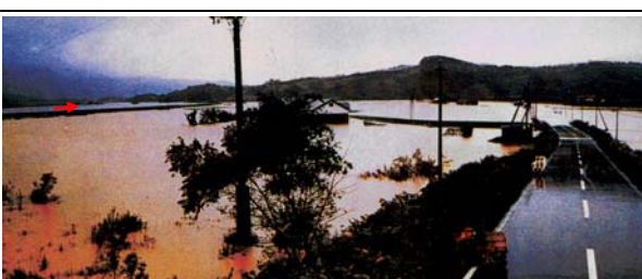
ひやみず 冷水地区道道北尻別蘭越停車場線冠水状況
