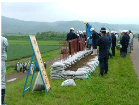
積み土のう工法
