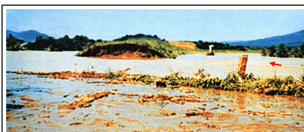
よなご 米子築堤破堤状況
