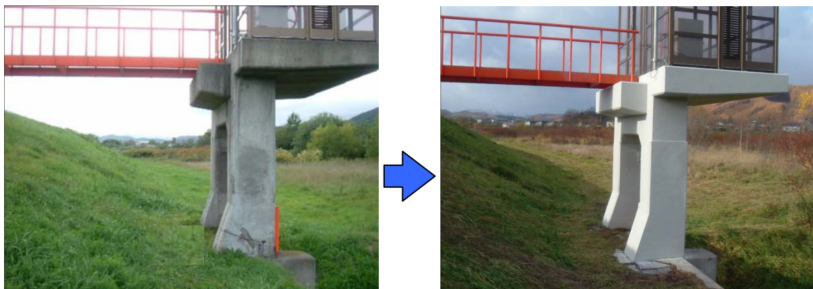
樋門門柱の補修
