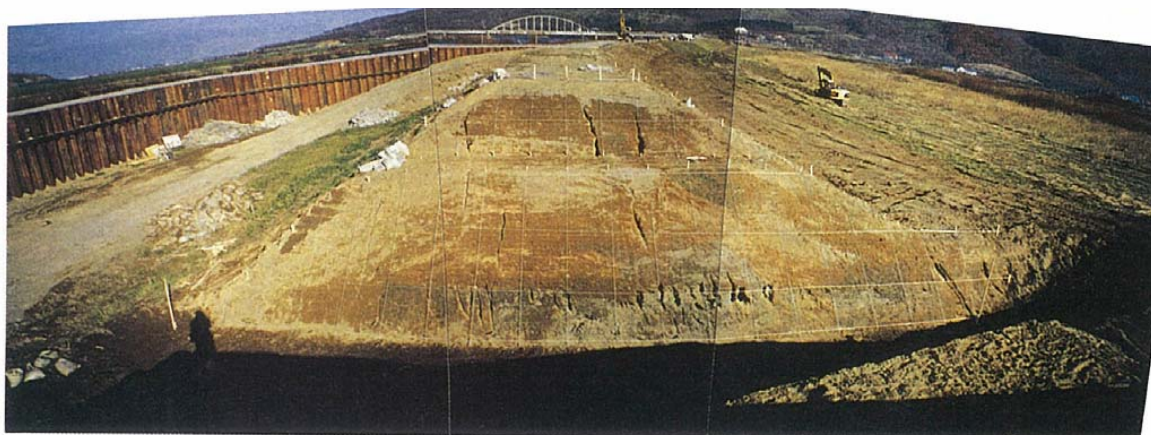
尻別川の堤防の 内部構造 (KP3.6付近)
