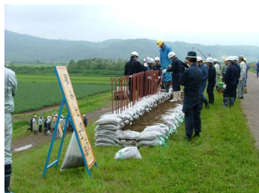
水防工法訓練
