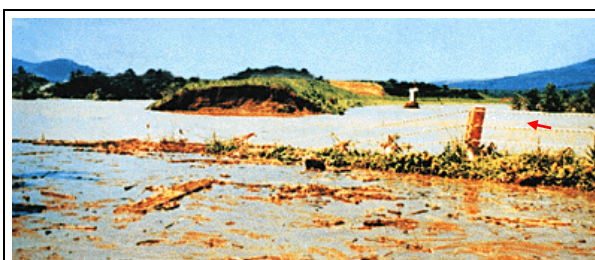
よなご 米子築堤破堤状況
