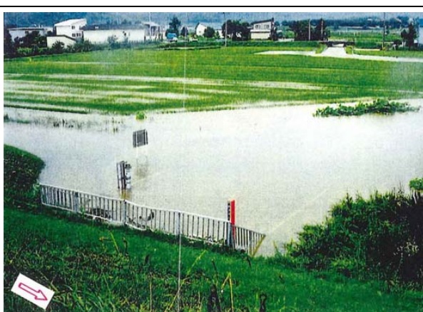
きゅうらんこし 旧蘭越築堤内水はん濫状況
