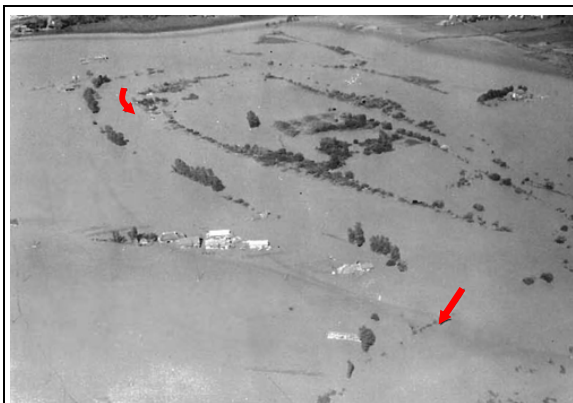
おおまがり 大曲地区はん濫状況
