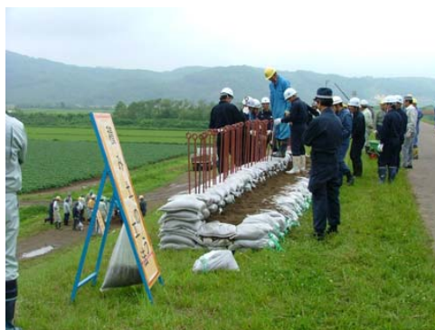
積み土のう工法
