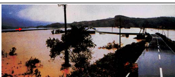
ひやみず 冷水地区道道北尻別蘭越停車場線冠水状況
