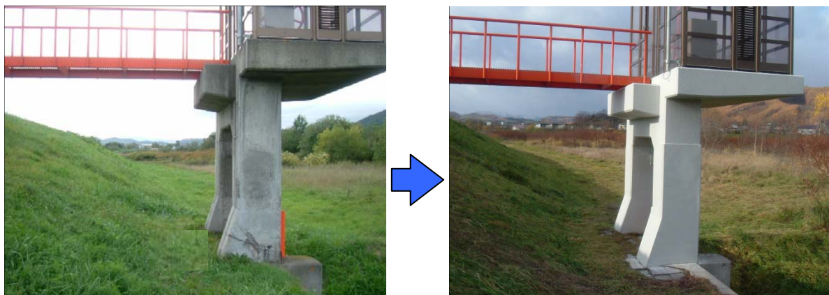
樋門門柱の補修
