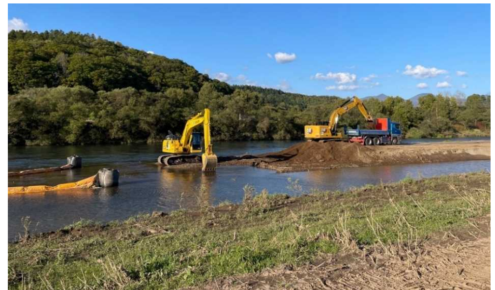
中州の掘削状況
