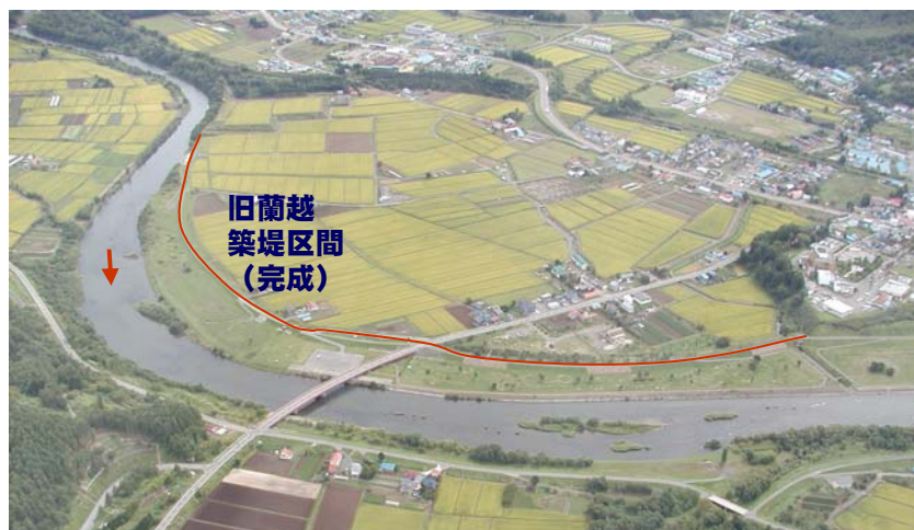
旧蘭越築堤区間 現在（平成18年）
