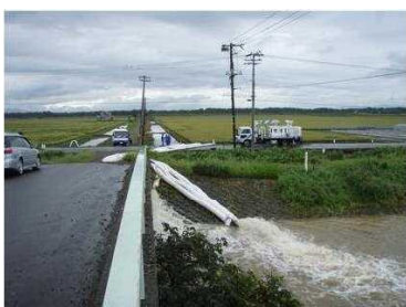
H22.8 低気圧による大雨 内水排除作業支援(芦別市) [自治体支援]
