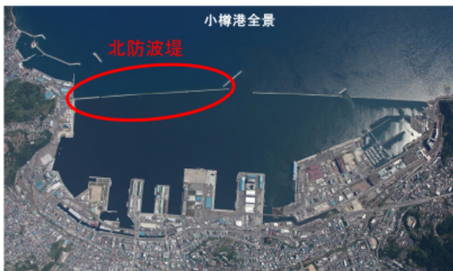
小樽港北防波堤の位置
