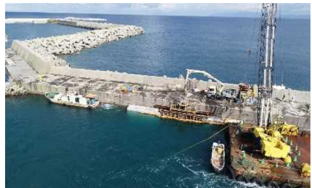
寿都地区 北防波堤改良状況
