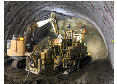
国道5号 塩谷防災 （塩谷トンネル掘削状況）
