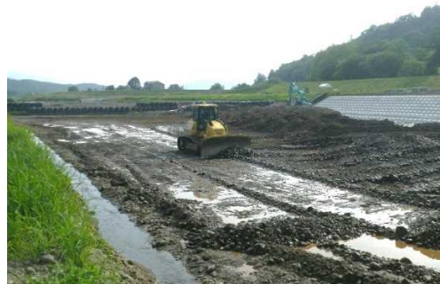
ICT 施工による敷均状況
