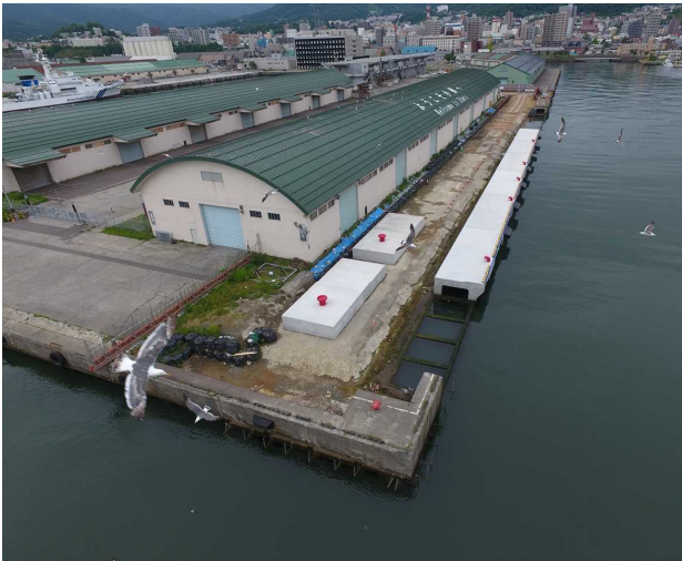
小樽港中央地区岸壁改良状況
