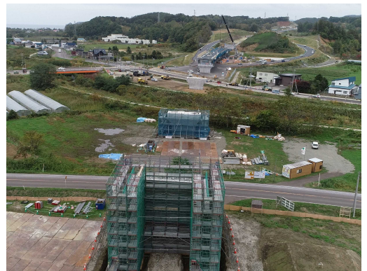
国道 5 号 倶知安余市道路（共和～余市） （登川大橋施工状況）
