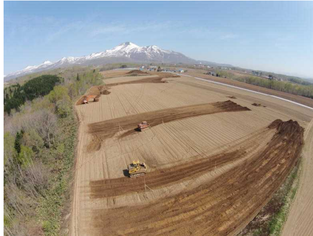
農地の区画整理工事の実施状況
