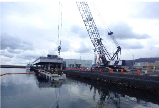
古平地区 水深 3.5m 岸壁改良状況
