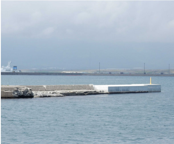
岩内港本港地区防波堤改良状況
