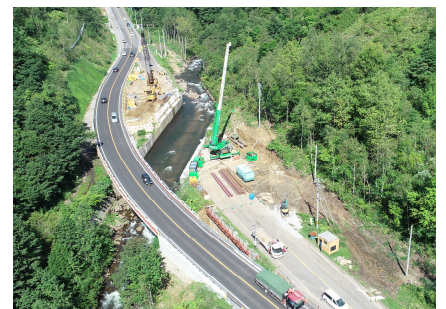
国道230号 喜茂別事故対策 （楓橋施工状況）
