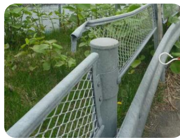
損傷した転落防止柵を補修
