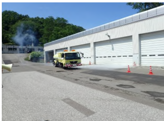
道路散水車による実演
