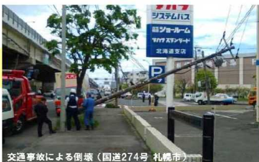
交通事故による倒壊（国道274号 札幌市）
