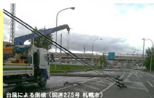
台風による倒壊（国道275号 札幌市）
