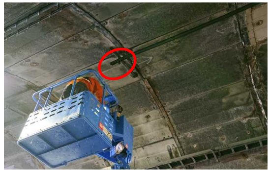
○ケーブル撤去状況写真
