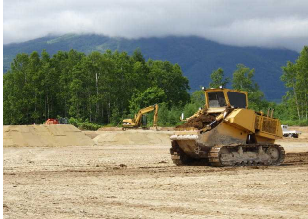
農地の区画整理工事の実施状況
