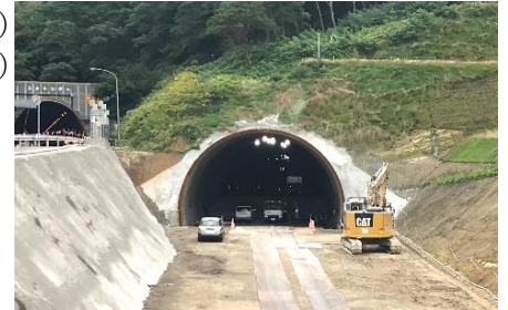
国道5号 塩谷防災 （（仮称）塩谷トンネル施工状況）
