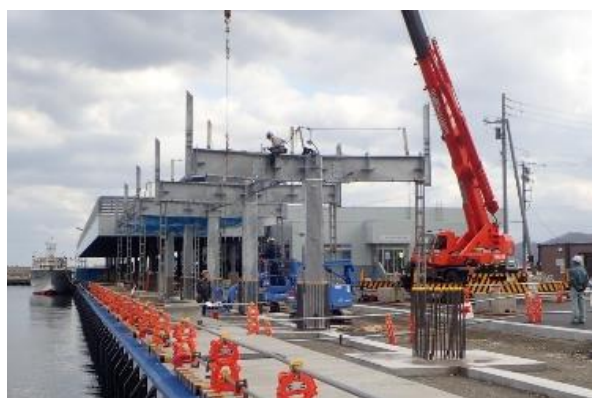
古平地区 水深 3.5m 岸壁整備状況
