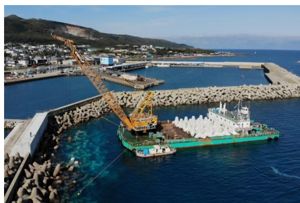
寿都地区 北防波堤整備状況
