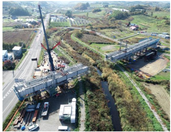
国道5号 倶知安余市道路（共和～余市） （（仮称）登川大橋架設状況）
