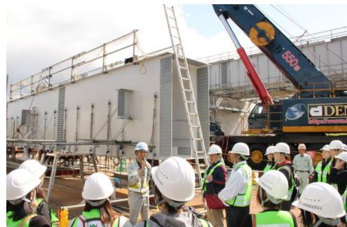
国道5号 倶知安余市道路（共和～余市） （i-Construction現場説明会状況）
