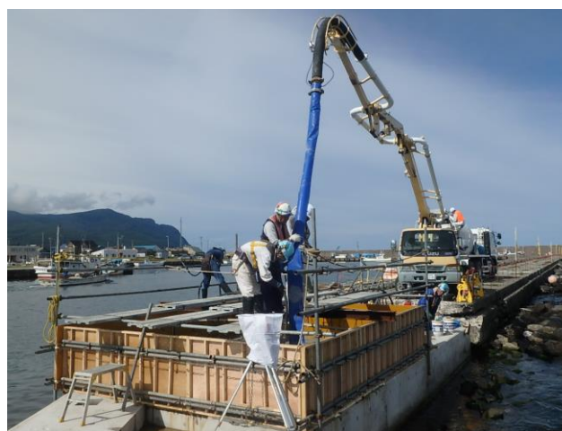
岩内港本港地区防波堤改良状況
