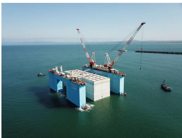
石狩湾新港北防波堤ケーソン進水状況
