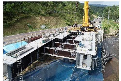
国道230号 喜茂別事故対策 （楓橋架設状況）
