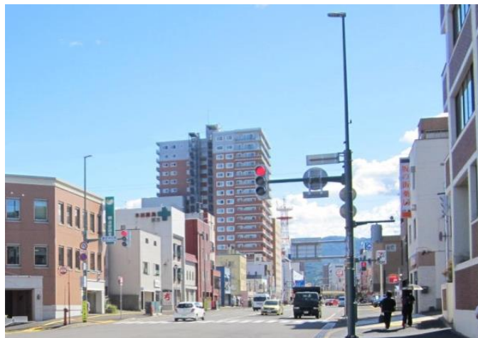
国道5号（小樽市稲穂）整備事例
