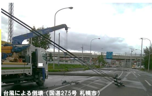
台風による倒壊（国道275号 札幌市）
