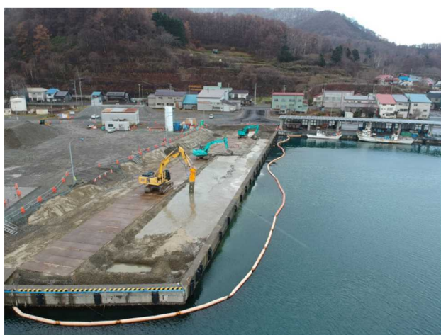
古平地区 水深 5.0m 岸壁(耐震)(改良) 整備状況
