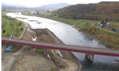
河道掘削状況
