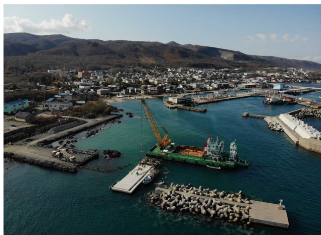
寿都地区 南ふ頭(護岸(南)等) 整備状況
