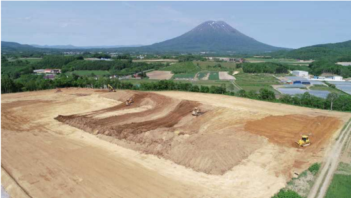
農地の区画整理工事の実施状況
