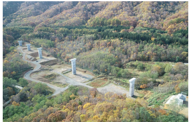
国道 5 号 倶知安余市道路（共和～余市） （仮称）銀山大橋
