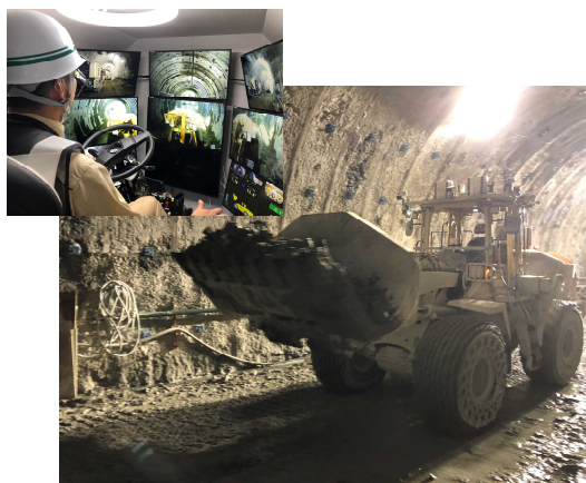
国道 5 号 倶知安余市道路（共和～余市） （ホイールローダの遠隔操作）
