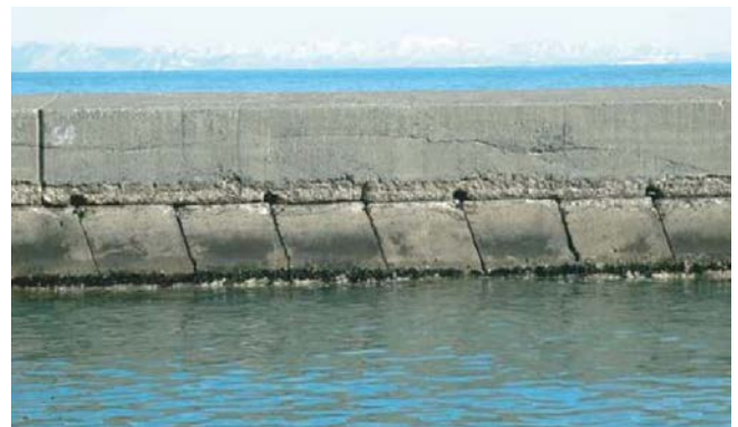
100年以上現存している小樽港北防波堤の現状
