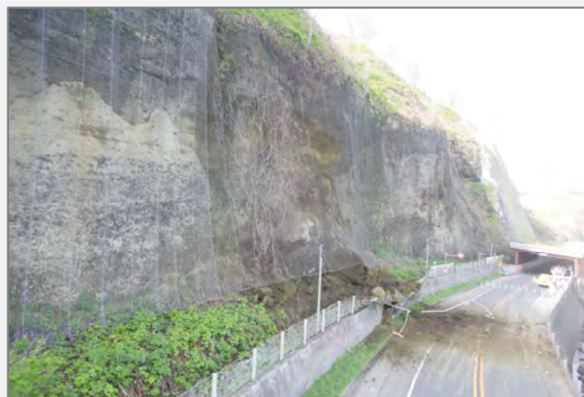
▲平成19年5月16日斜面崩壊状況①
