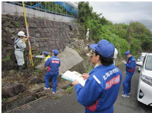
現地被災状況調査(道路班)
