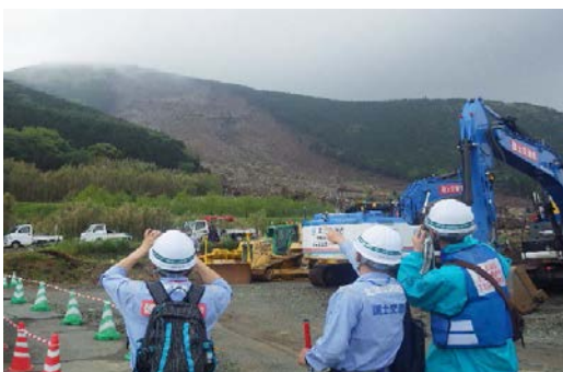
阿蘇大橋地区の監視状況(砂防班)
