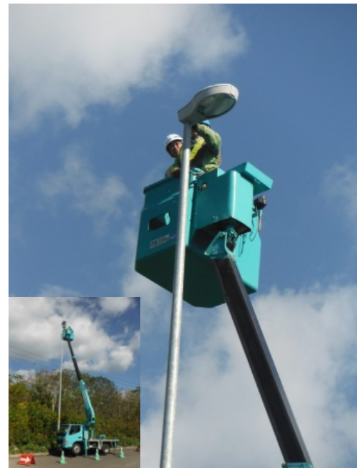
高所作業車による点検
