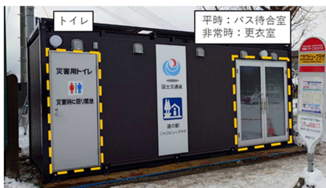
道内初の防災用コンテナ型トイレ(道の駅「ニセコビュープラザ」)
