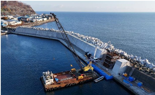
古平地区 東防波堤（改良）整備状況
