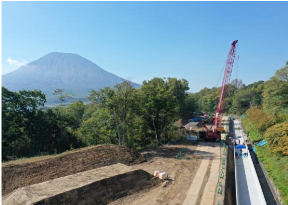
中後志地区 用水路改修工事の実施状況
