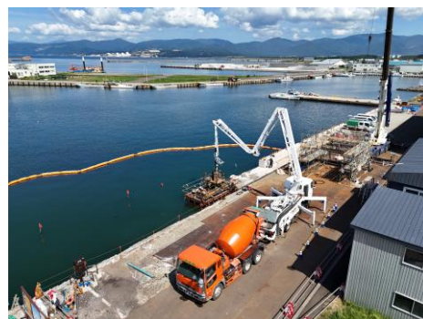
岩内港水深 3m物揚場 整備状況
