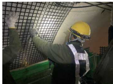
トンネル補修(剥落対策)
