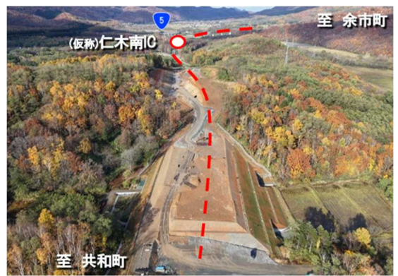
国道5号 倶知安余市道路(共和～余市)
