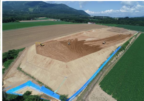
ニセコ地区 農地の区画整理工事の実施状況
