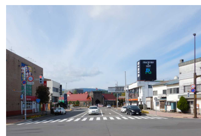
国道 229 号 余市駅前 電線共同溝（余市町）
