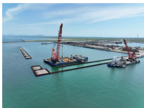
石狩湾新港水深 12m岸壁 整備状況
