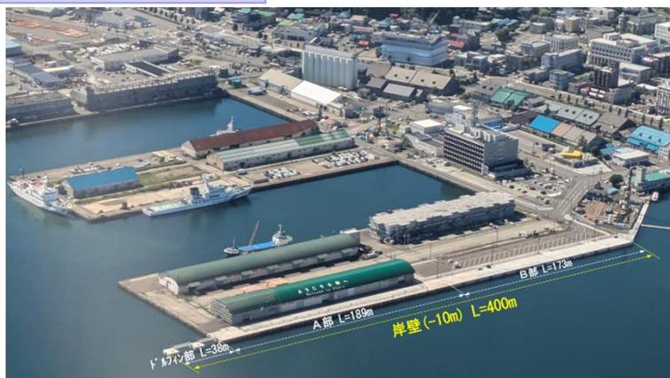
既存の岸壁2バースを1バースに改良。さらに、先端部にドルフィン2基を追加することで、14万GT級クルーズ船の係留を可能とした
